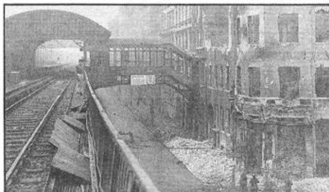
1945: Der schwer beschädigte Hochbahnhof Prinzenstraße.
